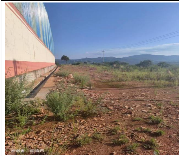
图 7 项目外侧墙体 1
