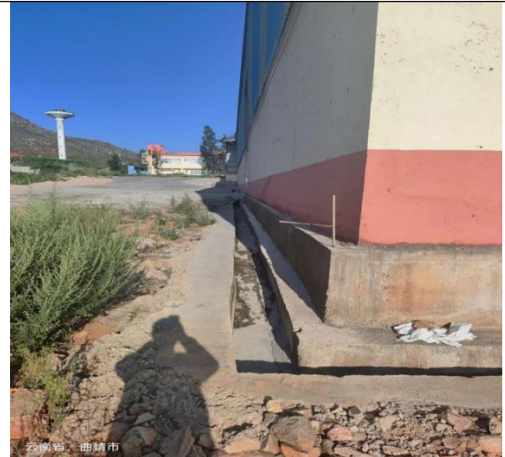
图 8 项目外侧墙体 2
