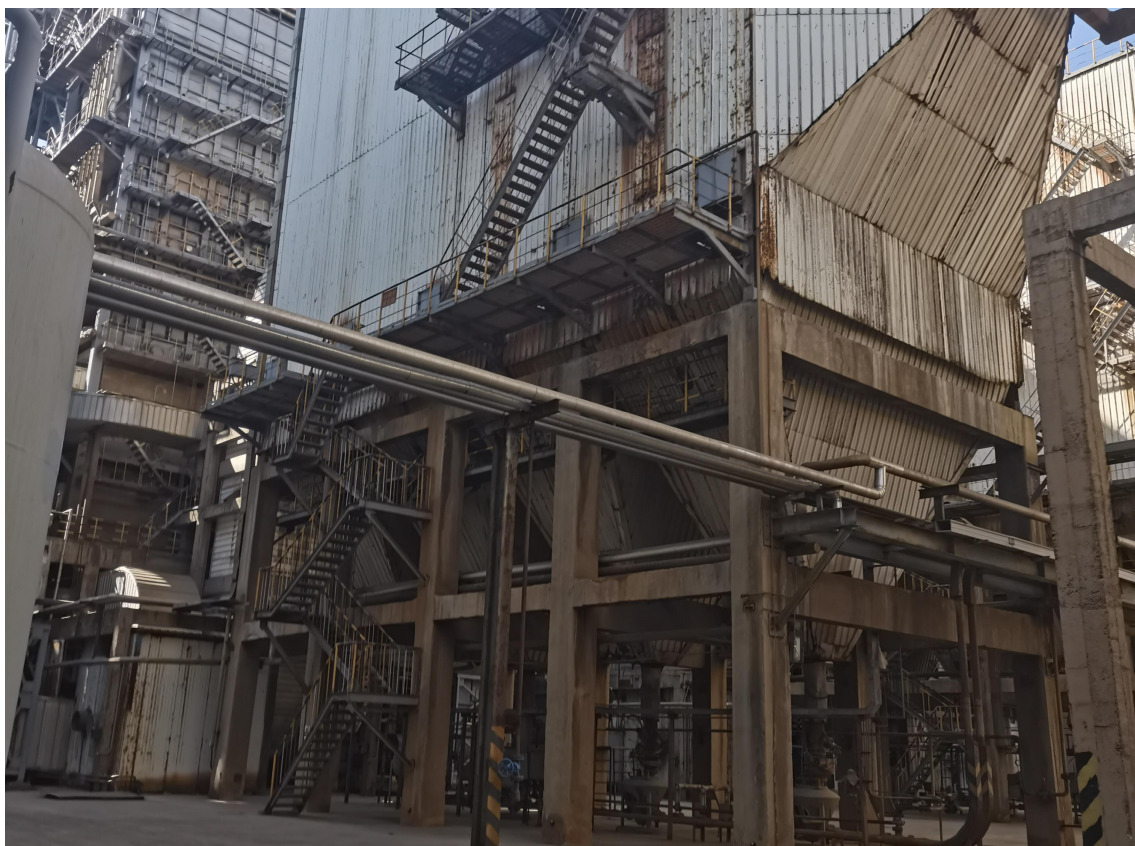
图 F1-1 除尘器改造位置（新建脱硫装置西面）
